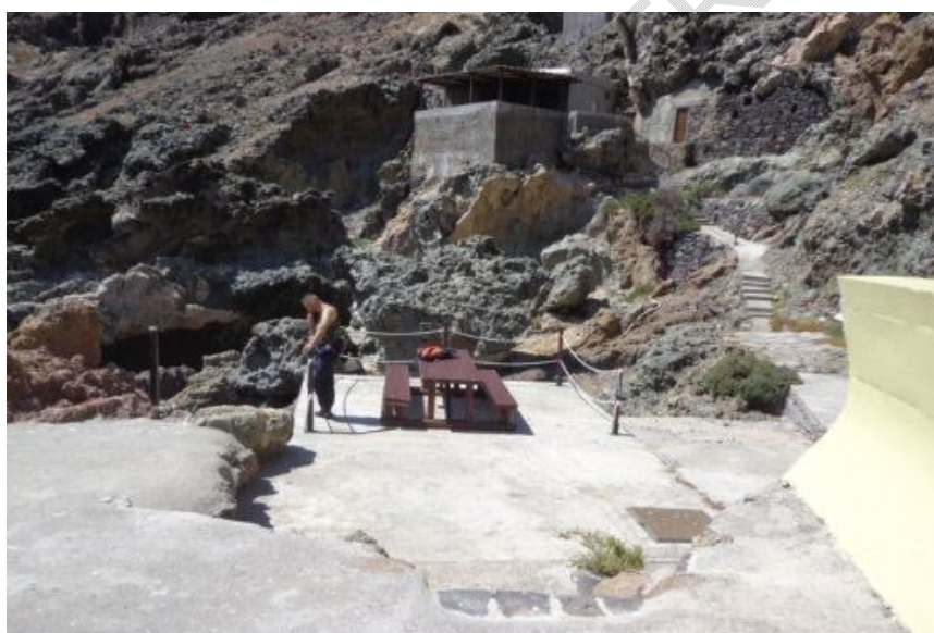
Fig. 17 – Exterior da Casa dos Vigilantes
