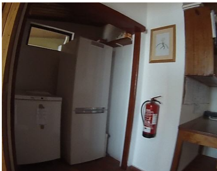
Fig. 4 23 – Interior da Casa dos Vigilantes – anexo destinado ao funcionamento provisório do PCLPMFS
